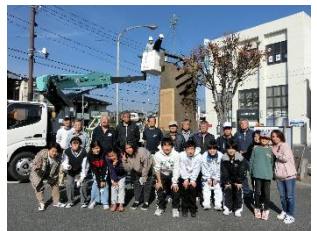
イルミネーション設置作業
