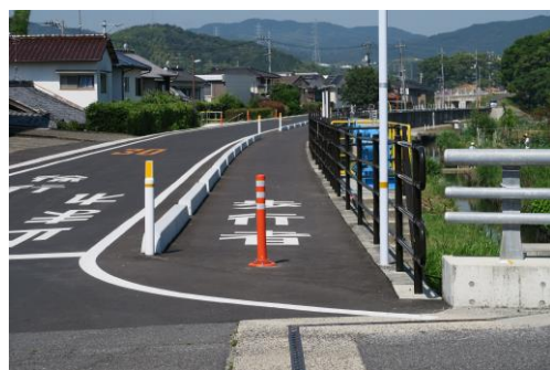
今津川護岸工事
