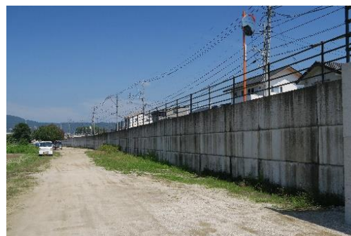
門前川護岸工事
